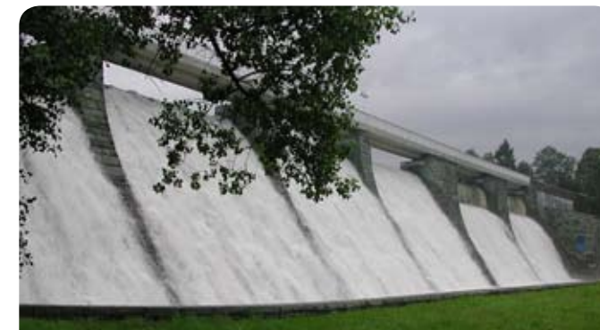
Überlauf beim Hochwasser 2002
